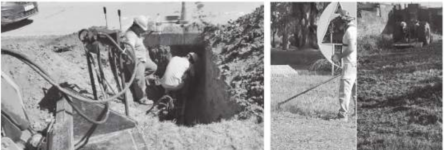
Trabajos de movimiento de suelos para la Coop. Alto Alegre
