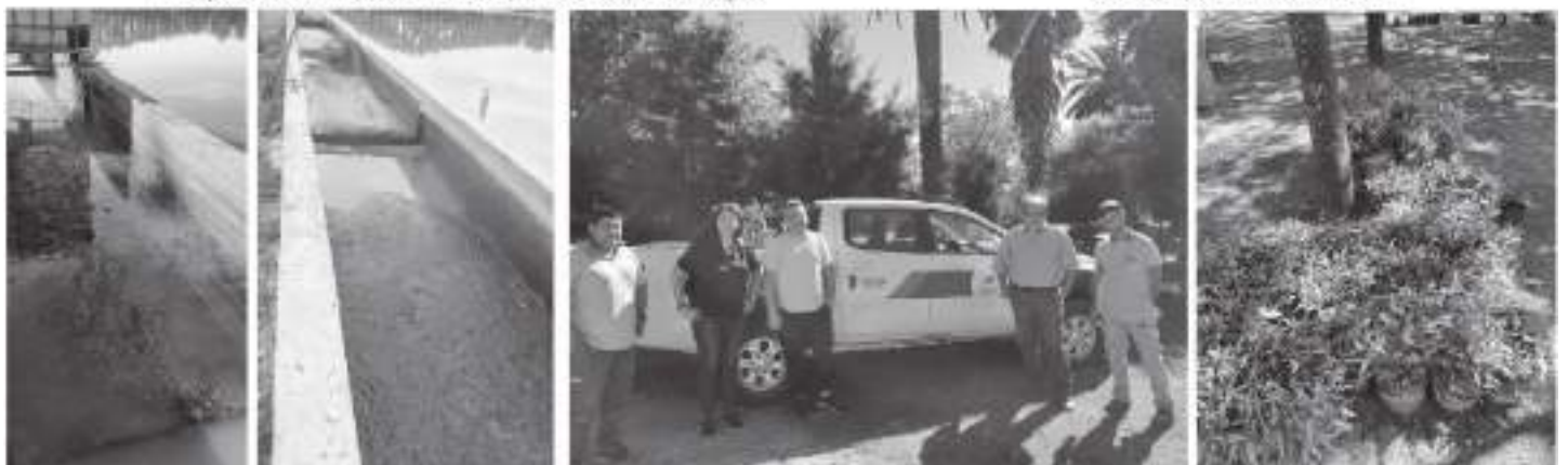
Construcción desarenador Módulo 1
