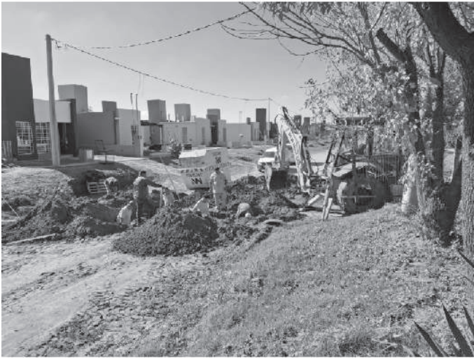
Obra Loteo Almirante Brown
