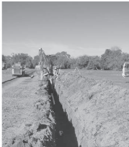
Obra Loteo A. Díaz
